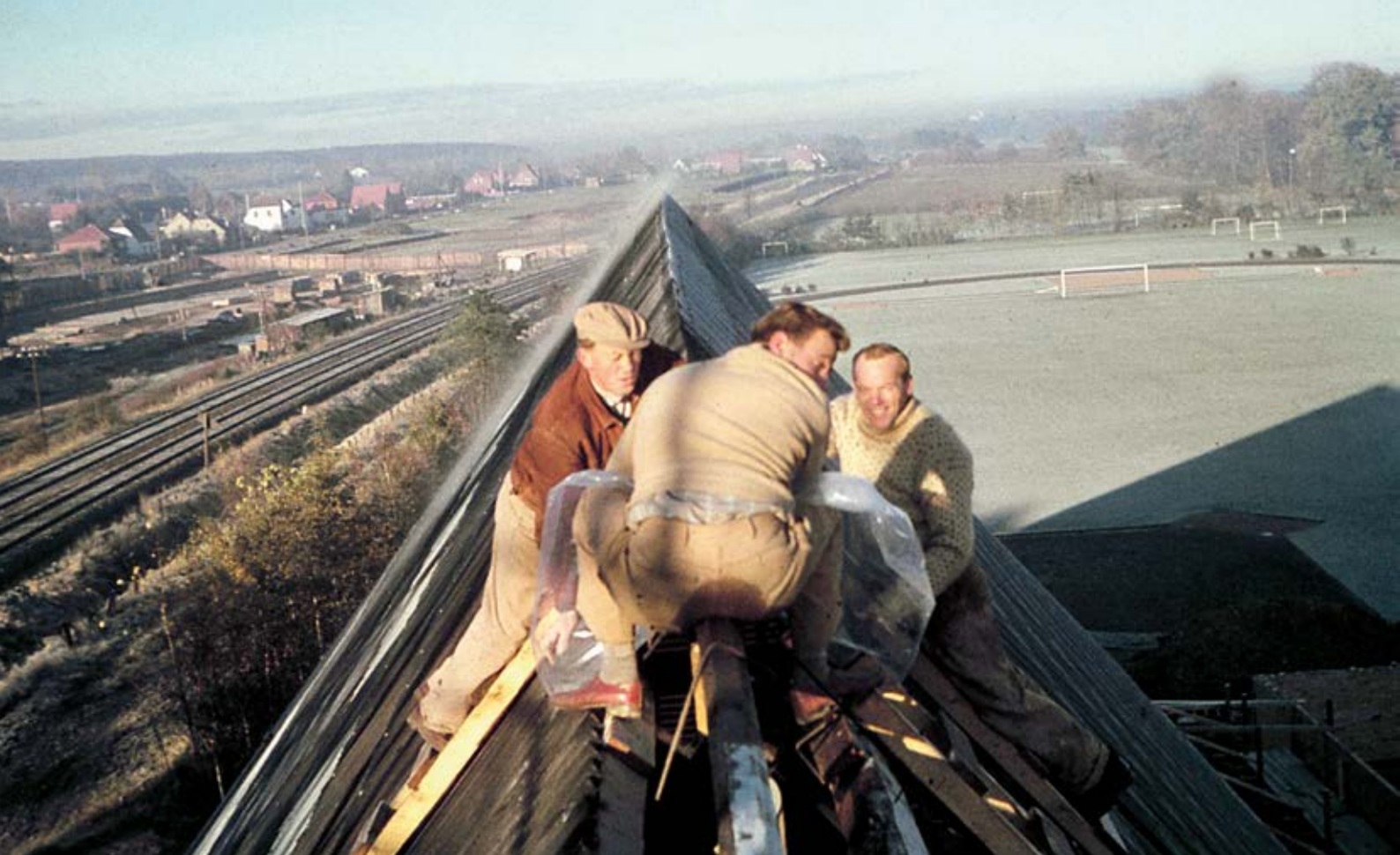
Herlufsholm Hallen blev opført af frivillige. Her er det Arthur Andersen, Keld Olsen og Jørgen Nielsson, der er på toppen med udsigt over banelegeme og idrætsanlæg.
